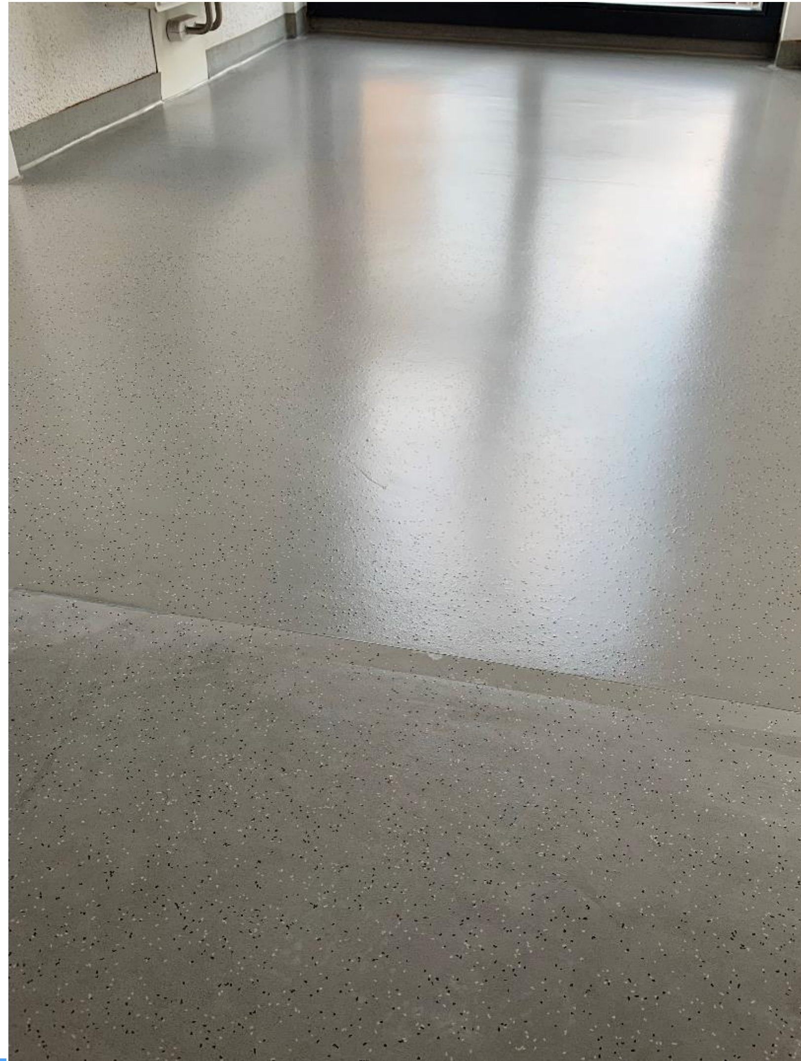
Durch starke Sonneneinstrahlung beschädigter Kautschukbodenbelag
