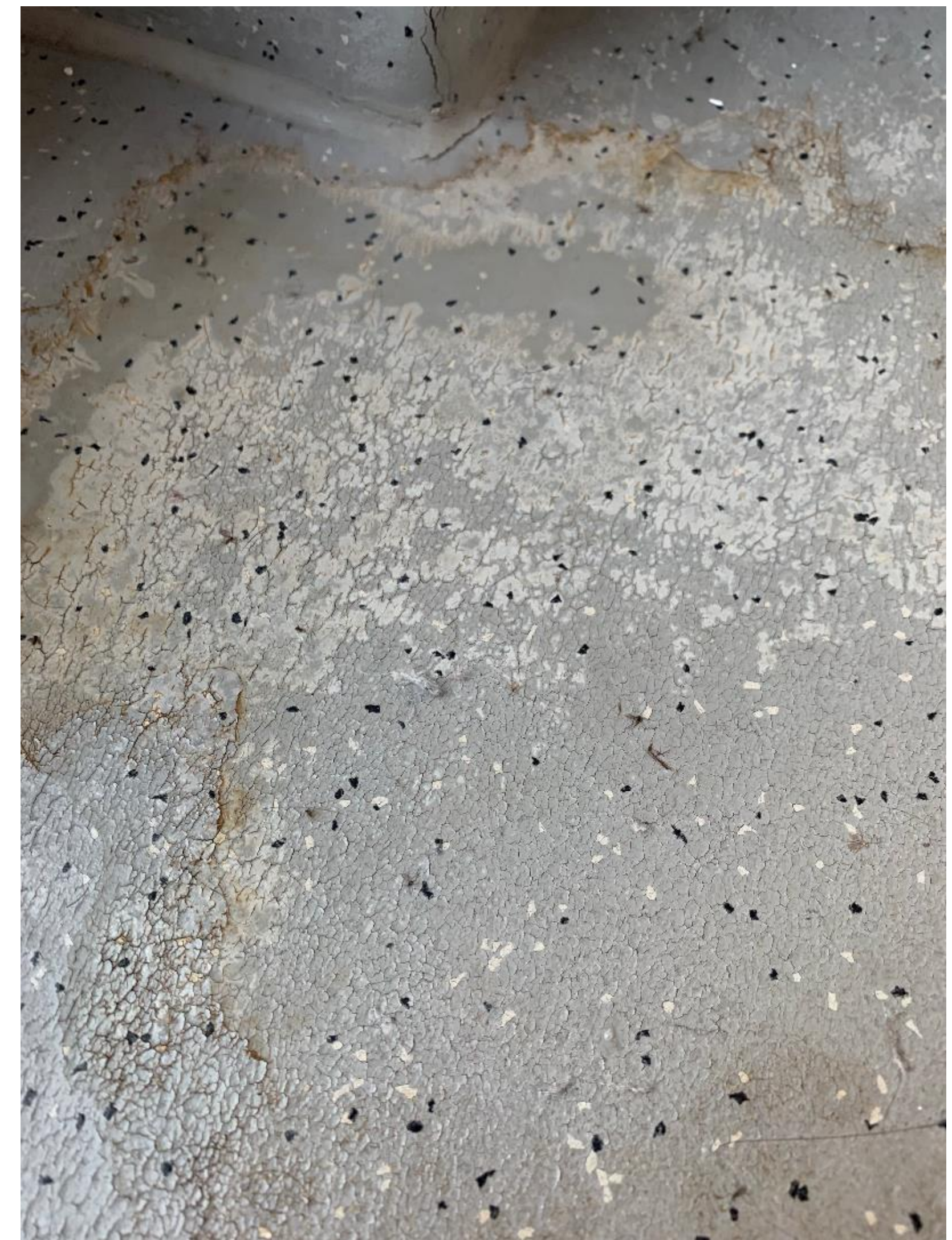
Durch starke Sonneneinstrahlung beschädigter Kautschukbodenbelag
