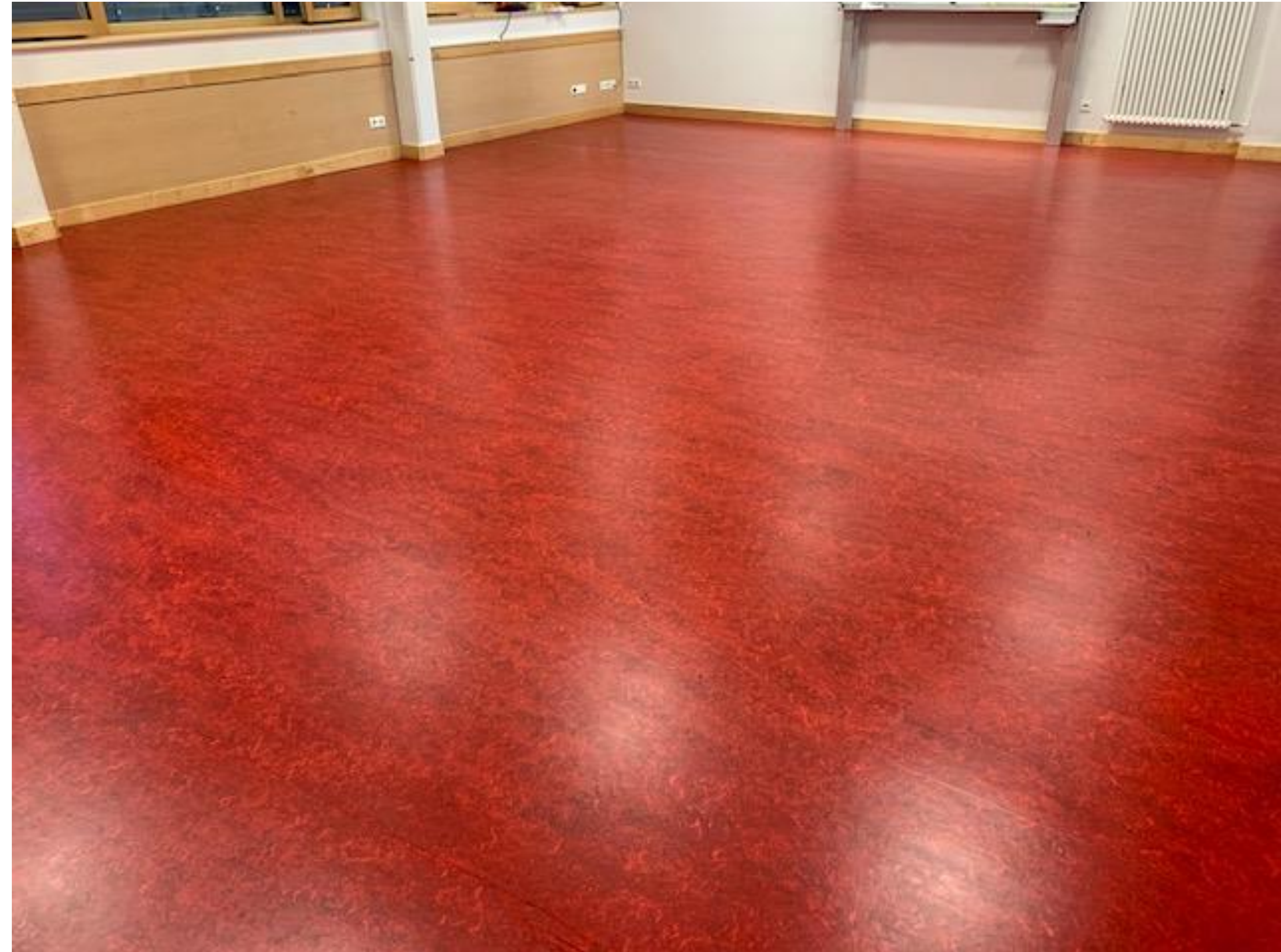
Linoleum eingepflegt mit Kiehl-Legnodur-Titan
