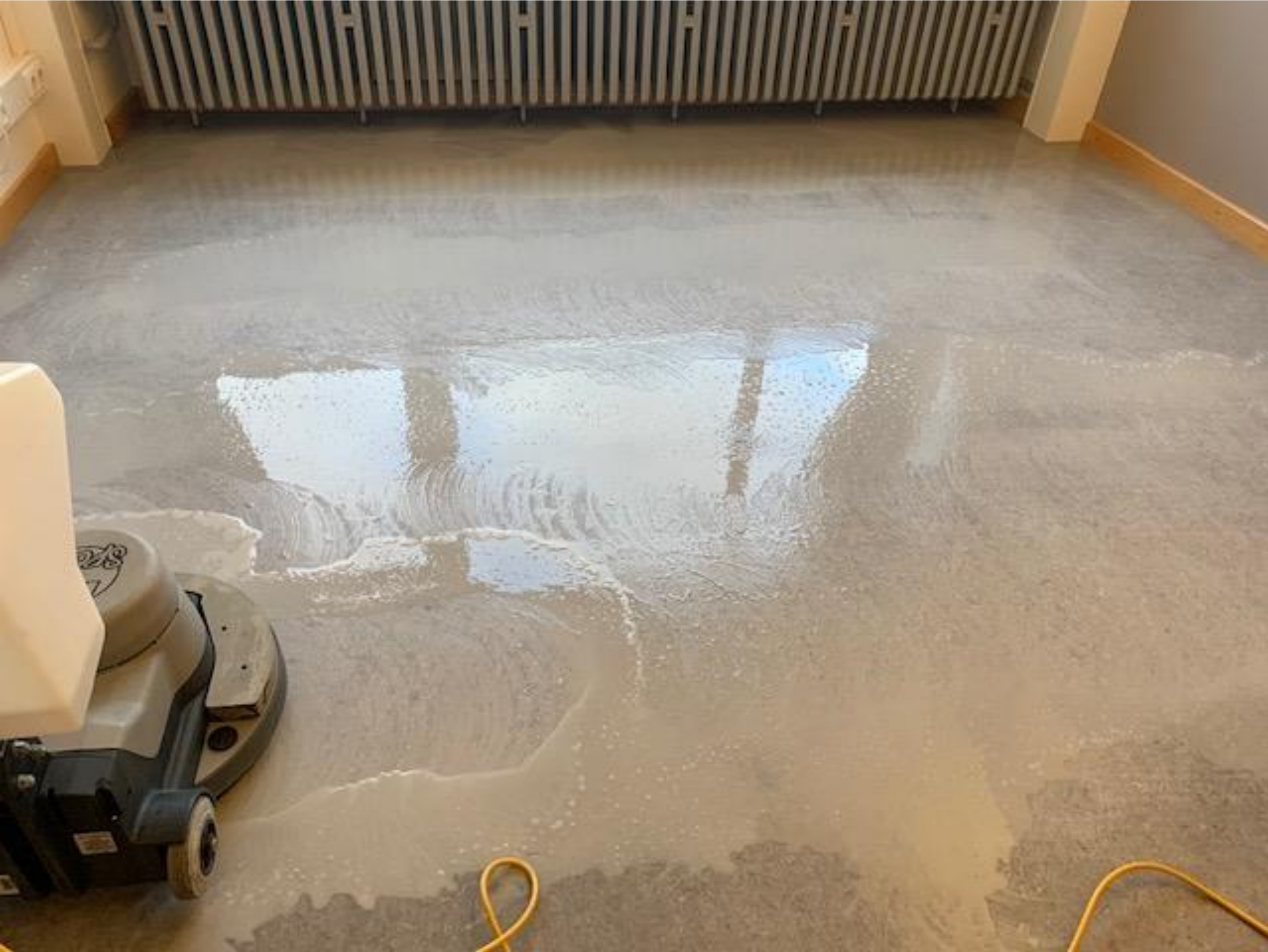
Grundreinigung des Linoleumbelages
