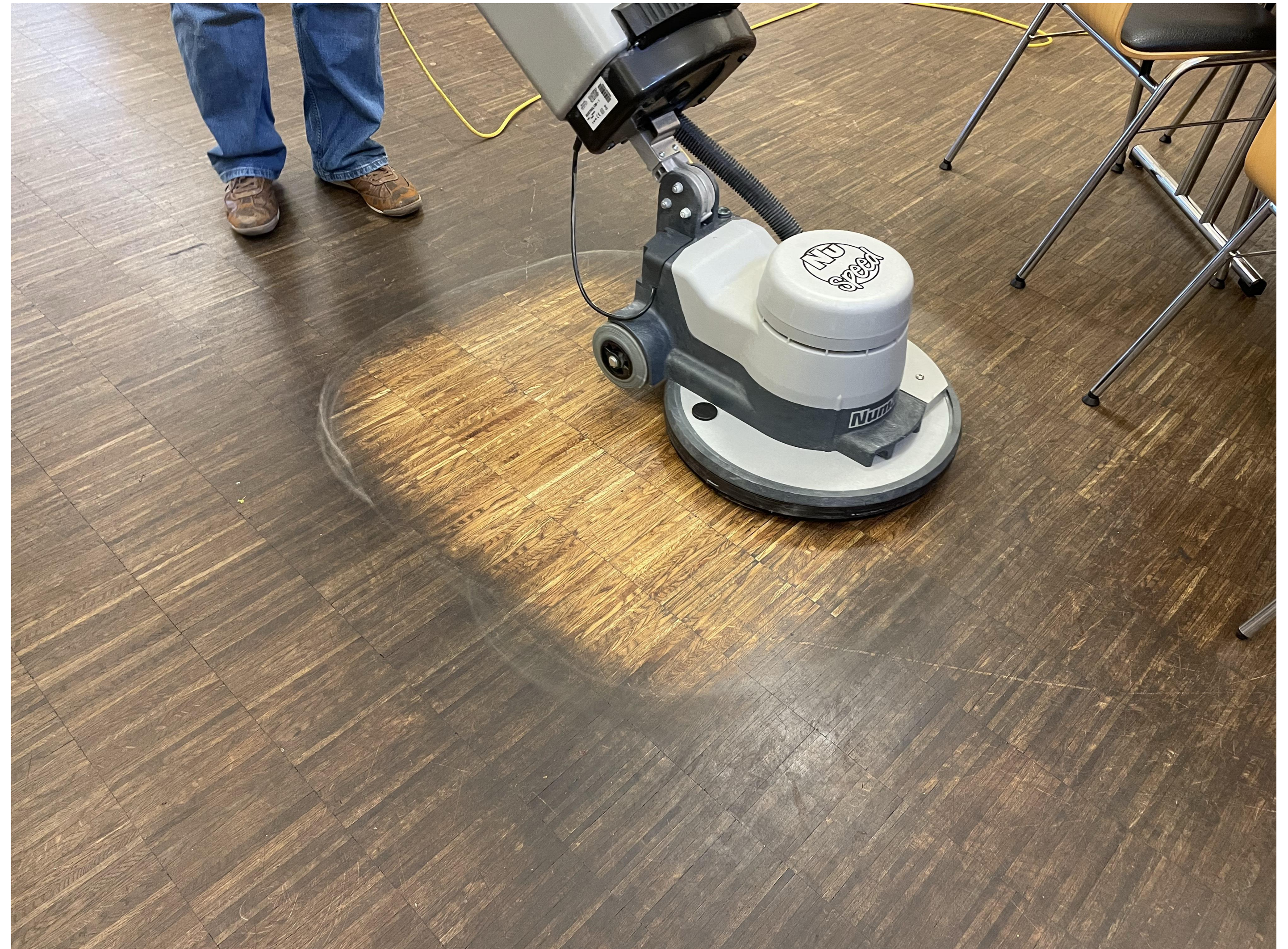
Hochkantlamelle vor Reinigungs- und Pflegemaßnahme.
