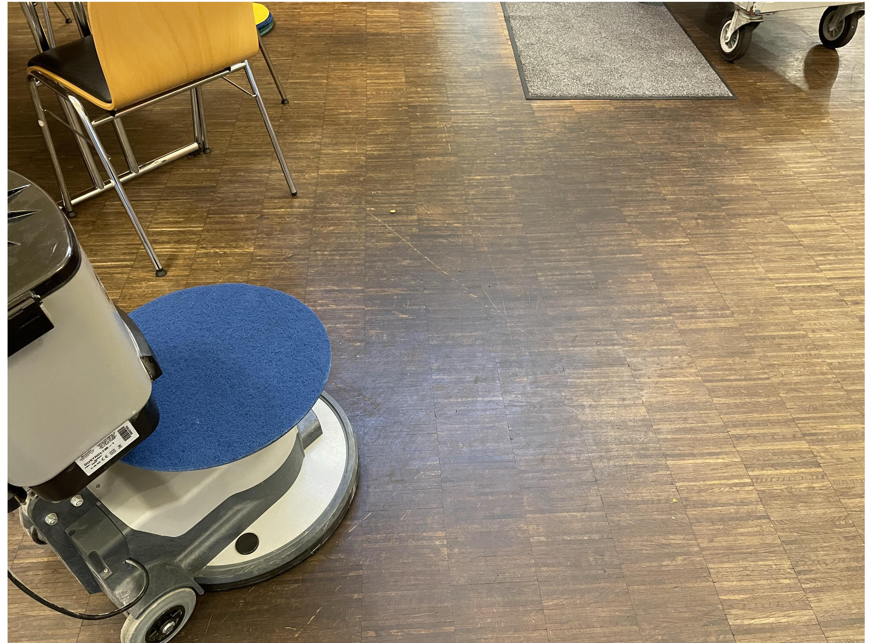
Hochkantlamelle vor Reinigungs- und Pflegemaßnahme.
