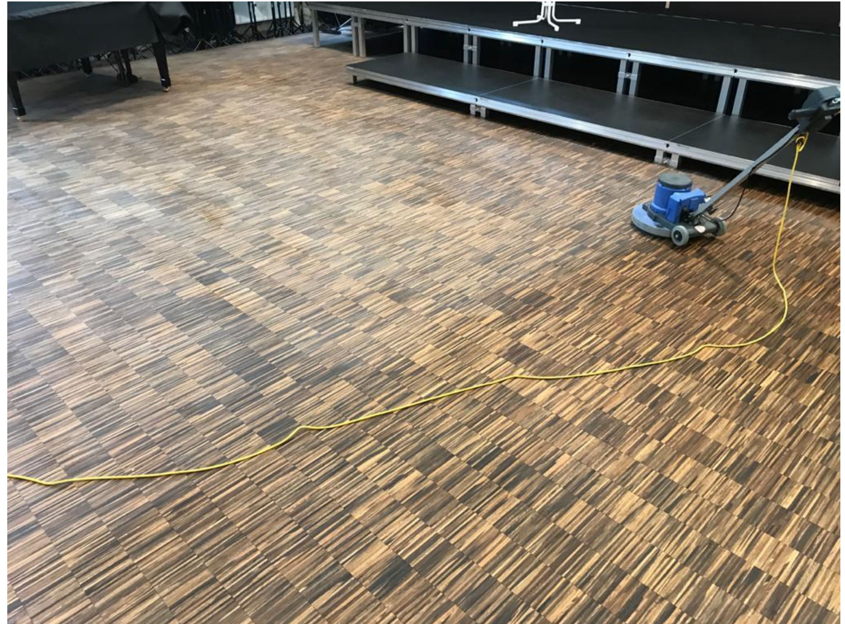
Hochkantlamelle vor Reinigungs- und Pflegemaßnahme.
